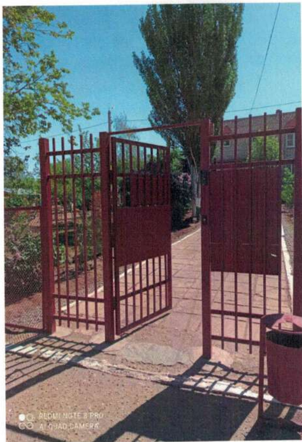
№2. Вход на территорию объекта (участок)
